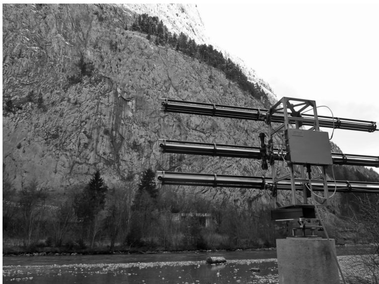
Fig. 1: Blick auf die Simmenfluh (Kanton Bern) mit dem Radargerät GPRI im Vordergrund. Unten an der Felswand ist die Nationalstrasse A6 erkennbar.
